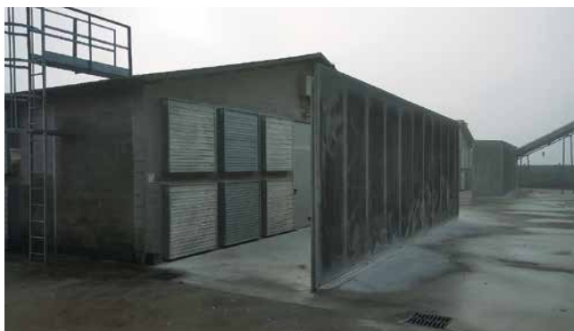
Figura 3 – Sistema finalizzato alla riduzione della dispersione delle polveri nell'ambiente circostante. Foto del Dr. F. Galuppo.
